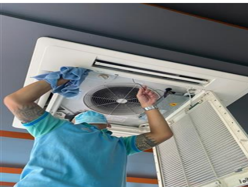
การล้างแผ่นกรองอากาศในพื้นที่ส่วนกลาง
