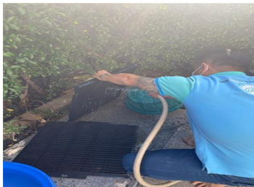
การล้างแผ่นกรองอากาศในพื้นที่ส่วนกลาง
