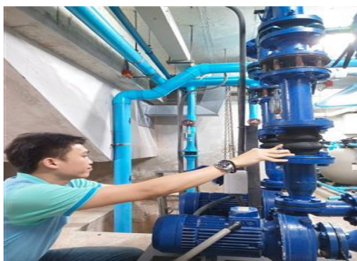
เจ้าหน้าที่ตรวจสอบรอยรั่วของท่อจ่ายน้ำ
